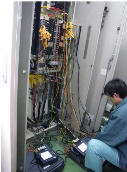
図 4 電力測定状況
